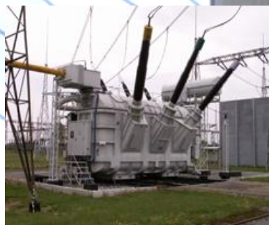
Transformator ridicător de tensiune
